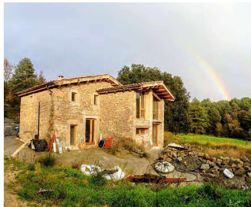
Projecte de rehabilitació integral Cal Gitano | Celobert cooperativa
